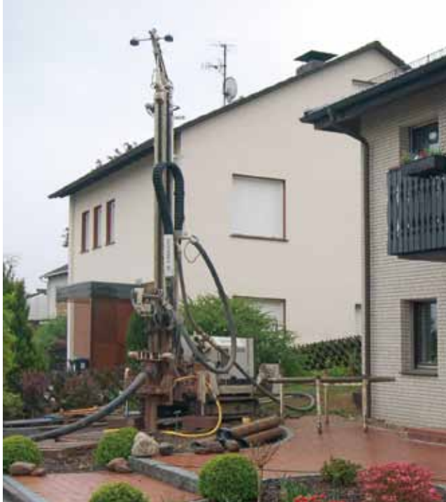
Bohrung für eine Sole/Wasser-Wärmepumpe
