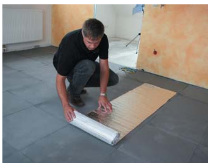
Nach der Säuberung des Untergrundes und dem Verlegen der Dämmplatten wird die Heizmatte ausgerollt. Dabei darauf achten die Heizleiter nicht zu kreuzen
