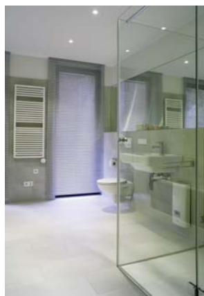
Attraktiv gestaltete Bäder mit energieeffizienter, bedarfsgerechter Warmwasserversorgung über elektronische Durchlauferhitzer
