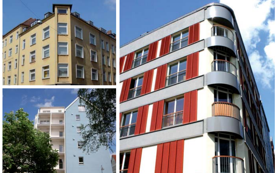
Das Objekt Schaufelder Str. 9 vor und nach der Sanierung (o. li und re.). In der Seitenansicht der sanierten Gebäude sind die Öffnungen für die Lüftungsgeräte der einzelnen Wohnungen zu erkennen (u. li.)
