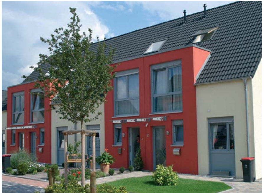
In den eigenen vier Wänden hat sich Familie Kern den Wunsch nach Unabhängigkeit von fossilen Energieträgern wie Öl oder Gas erfüllt: mit einem umweltfreundlichen Wärmepumpen-Heizsystem
